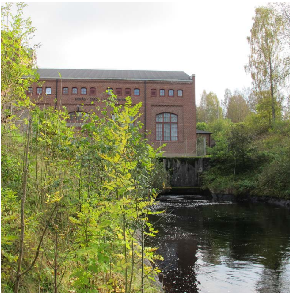
Figur 11. Haby kraftverksdamm nedströms ifrån. Foto: Niklas Egriell.
