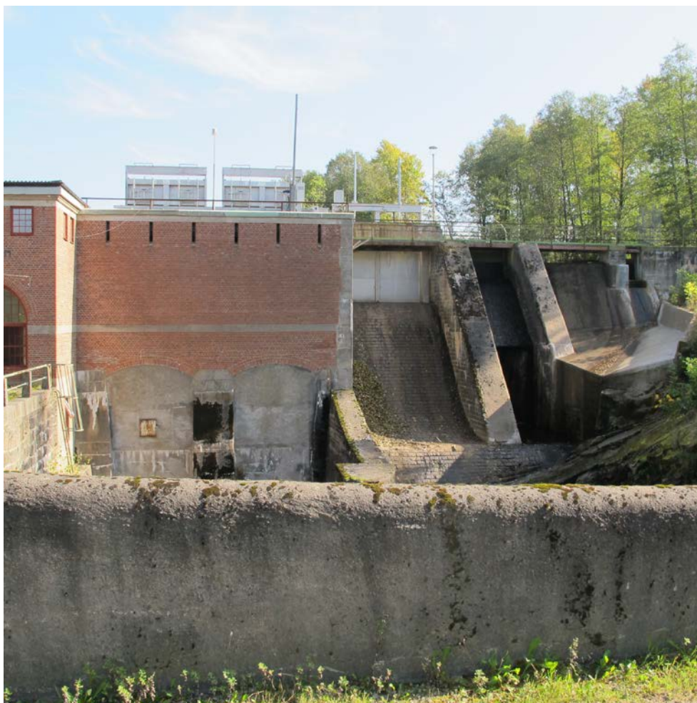
Figur 10. Hulta kraftverksdamm nedströms ifrån. Foto: Niklas Egriell.
