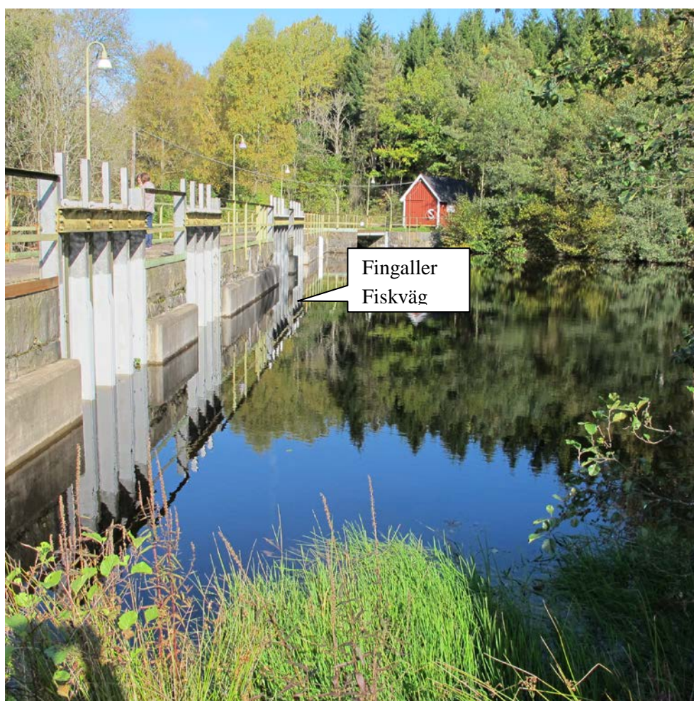
Figur 18. Fingaller kan installeras i intaget till intagskanalen och fiskväg skapas genom bl a upptröskling i naturfåran. Foto: Niklas Egriell.
