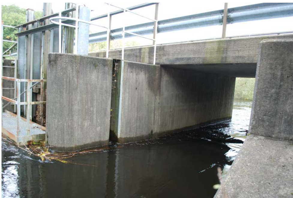
Figur 12. Fävrens reglering med en luckförsedd fåra och två utan luckor (varav en syns på bilden). Foto: Andreas Martinsson.
